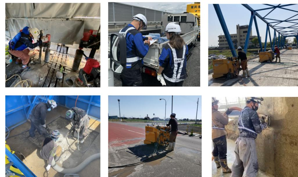
一年を通じて日本中の高速道路上及びその橋脚・橋台の劣化コンクリートを超高压水により除去し、尚且つ、使用済水(汚水)を濁度・pHを基準値まで処理することで雨水として再利用可能な水質まで戻し『つくる責任・つかう責任』を果し続けてきた。
